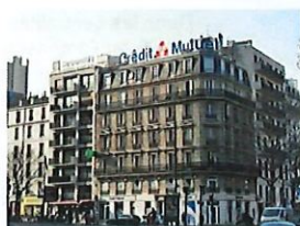
Publicités et enseignes sur toiture
