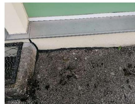
③ Façade arrière de l'école, côté rue J. Ferry – fissure au niveau du soubassement
